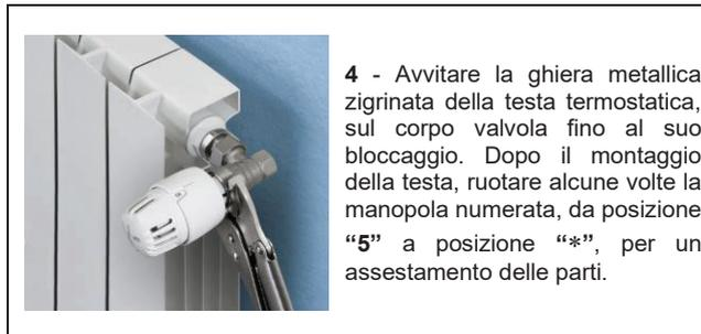
**4** - Avvitare la ghiera metallica zigrinata della testa termostatica, sul corpo valvola fino al suo bloccaggio. Dopo il montaggio della testa, ruotare alcune volte la manopola numerata, da posizione **"5"** a posizione **"\***", per un assestamento delle parti.
