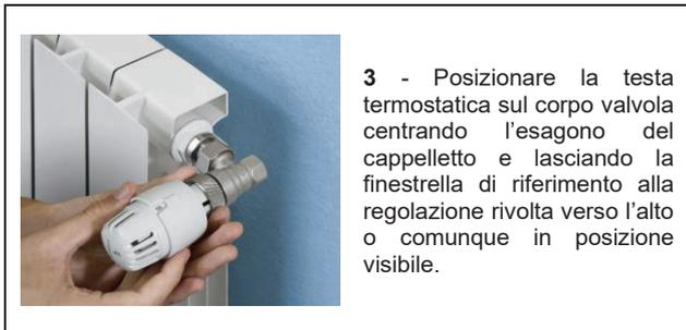
**3** - Posizionare la testa termostatica sul corpo valvola centrando l'esagono del cappelletto e lasciando la finestrella di riferimento alla regolazione rivolta verso l'alto o comunque in posizione visibile.
